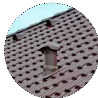
TVAROVKA ODVĚTRÁNÍ KANALIZACE
