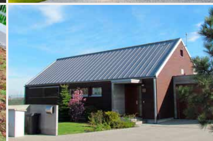
PLECHOVÁ STŘECHA SATJAM
